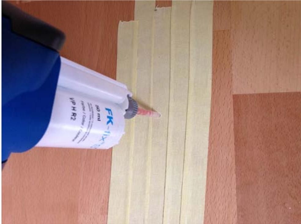
8. Solange Material einbringen, bis an der gegenüberliegenden, ebenfalls abgeklebten Stelle austretendes Harz sichtbar wird.
